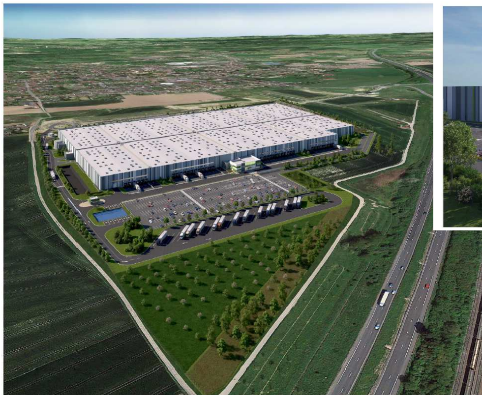
Vue aérienne du projet depuis l'angle Sud vers le Nord
